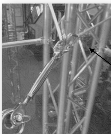
Figura 1: Colocar la eslinga alrededor del anclaje
